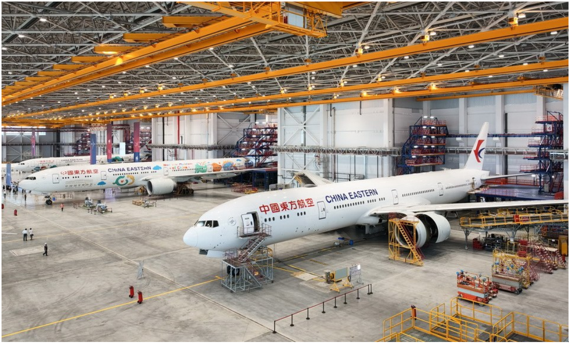
亚洲最大宽体机维修机库 在上海投入运营
