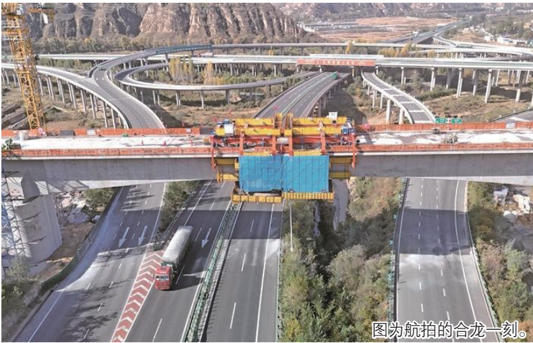
图为航拍的合龙一刻。
